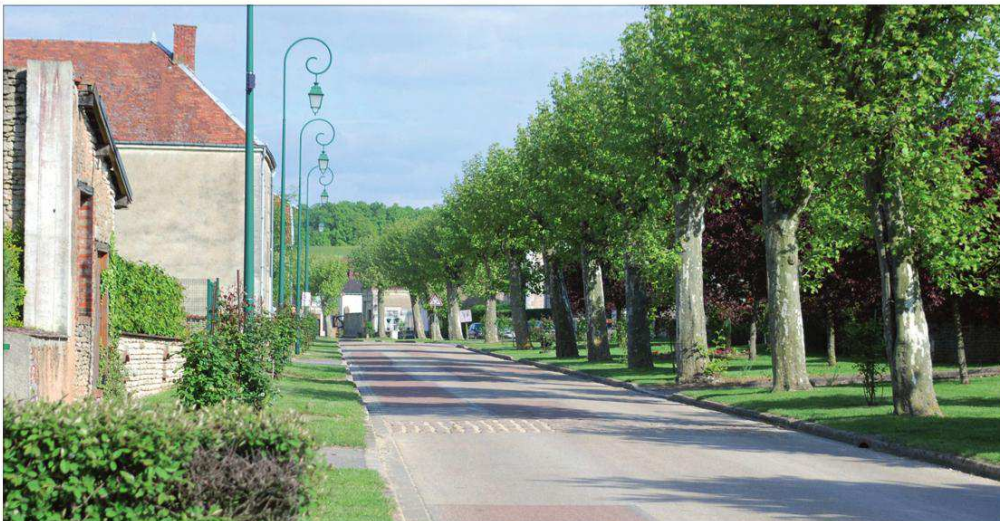
Trottoirs plantés et enherbés particulièrement adaptés au contexte rural.
