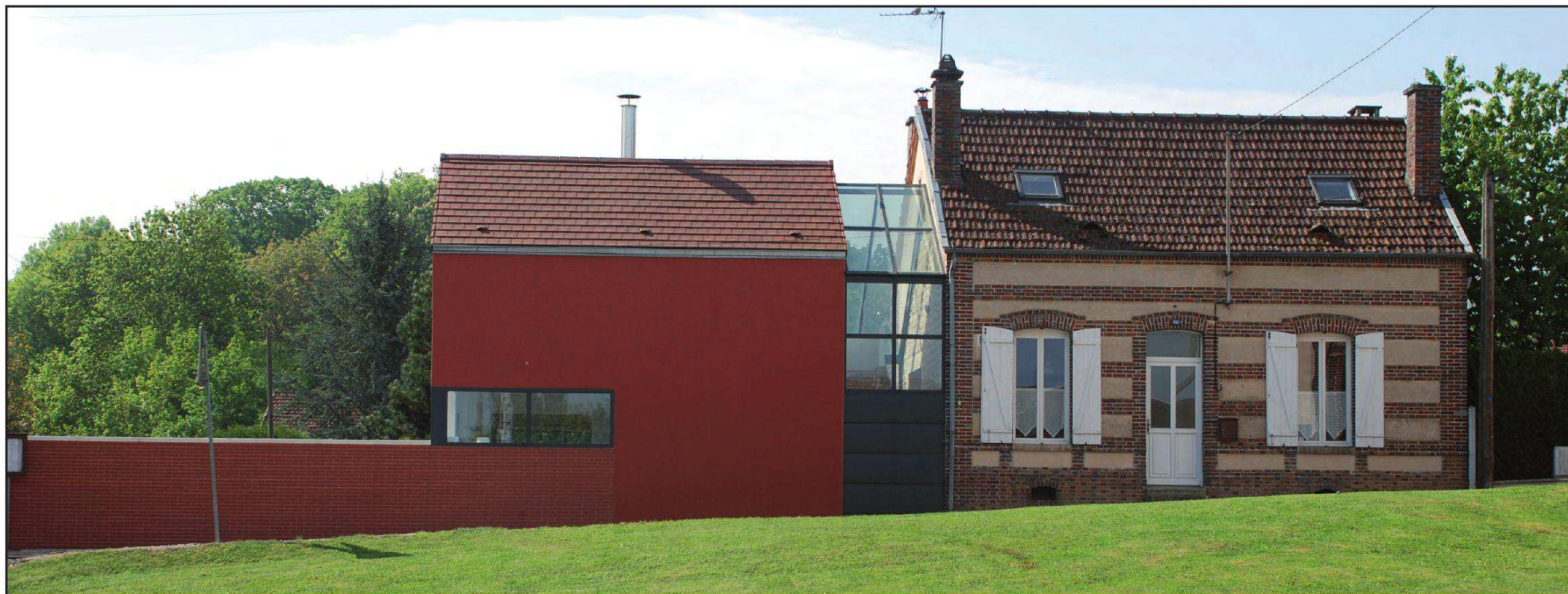
Extension architecturale dont la volumétrie est en rapport avec la maison d'origine.
