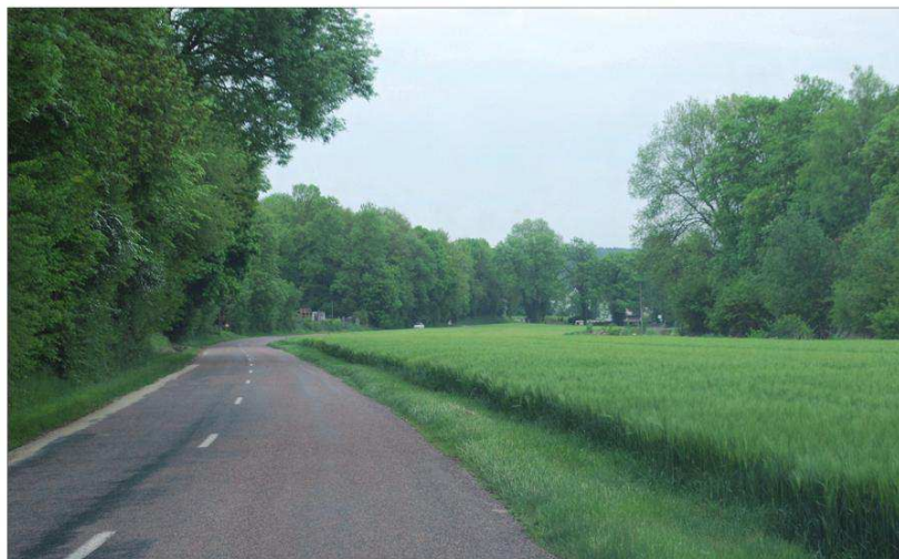
Route discrète installée en limite de boisement et ouverte sur l'espace agricole dans la vallée de l'Aube.
