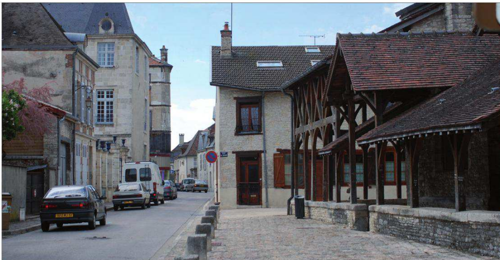
Traitement des trottoirs avec des matériaux nobles qui répondent bien à l'architecture.
