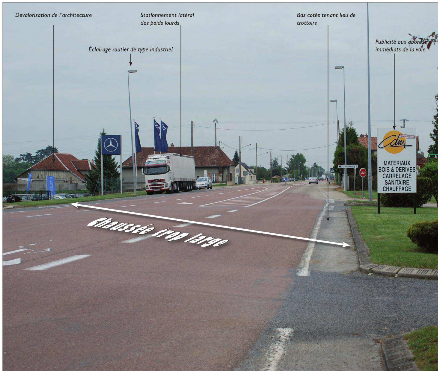
Traversée de village démesurément large. Les aménagements de ce type engendrent des comportements routiers gênants, voir dangereux pour les piétons.
