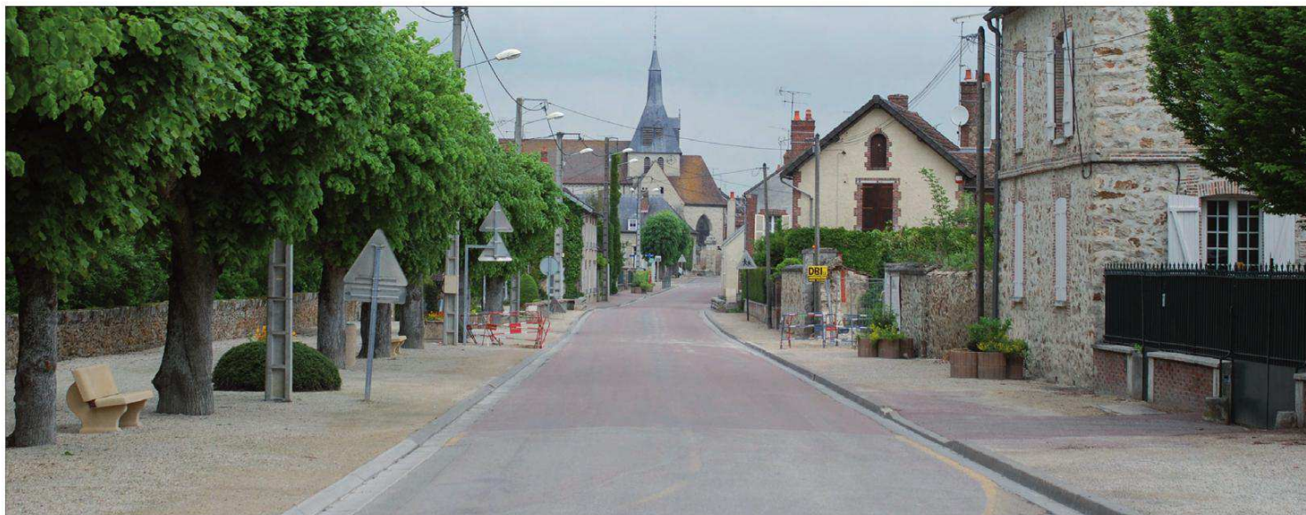
Pont-sur-Seine : aménagement de larges trottoirs en stabilisé et chaussée en bitume rouge (plus discret que le bitume noir)
