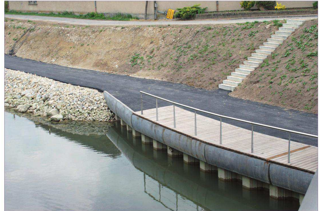
Ancien canal de la Haute-Seine : les matériaux employés pour l'aménagement des berges sont peu adaptés à un contexte rural (métal, béton, enrobé...).
