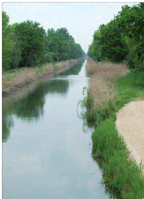
Berges du canal de la Haute-Seine.
