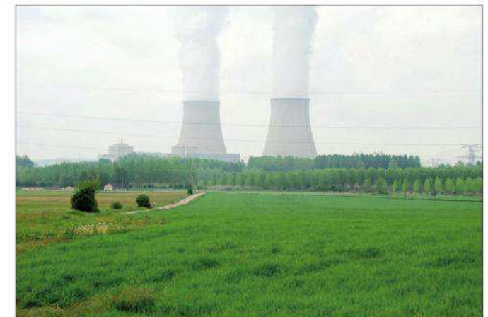
Silhouette de la centrale nucléaire, très massive et visible de très loin.
