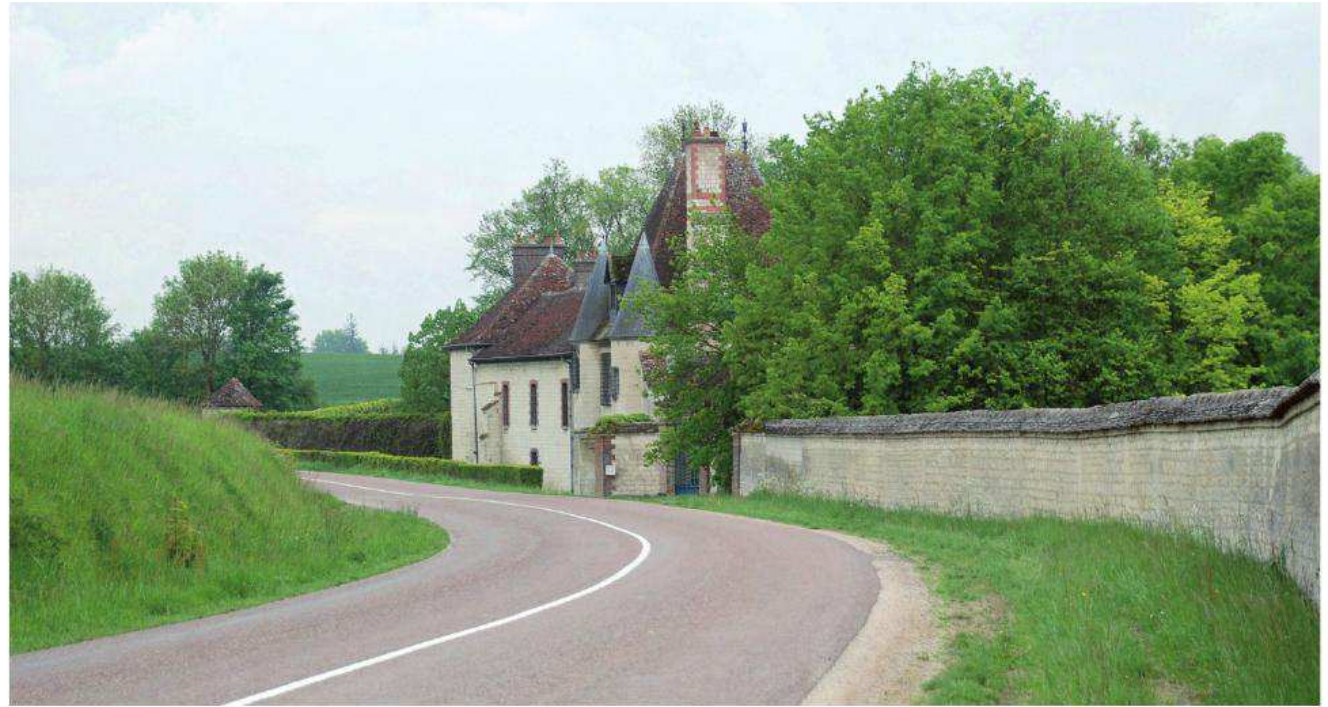
Un patrimoine architectural remarquable ; ici, le château de Vermoise.
