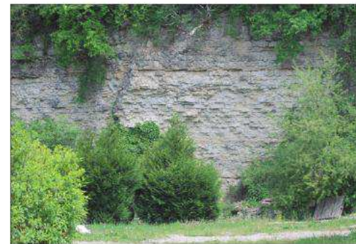
Falaise de calcaire à Villemorien, dans le Barrois, mise à nu pour la construction. (calcaire du Jurassique)
