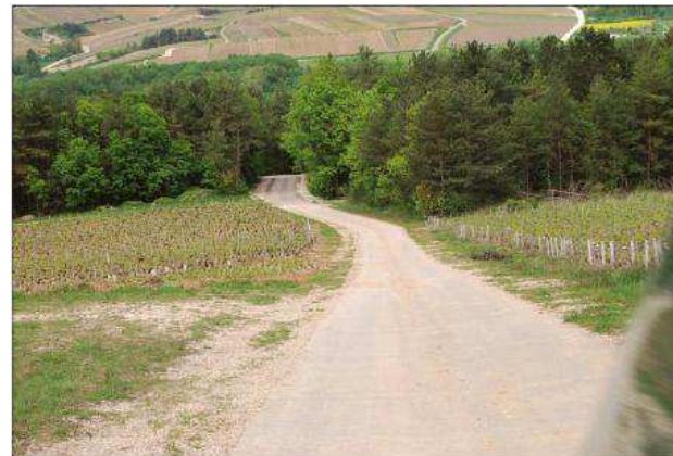
Multiples problèmes liés à la production intensive de champagne et à la pression exercée par la délimitation AOC : des bâtiments mal implantés et banalisant, des routes bétonnées, dessinées face à la pente plutôt qu'en lacets, nivellement au bulldozer des pentes pour accroître les surfaces cultivables...
