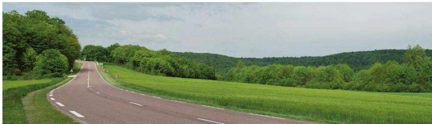
Route bien implantée par rapport au relief, RD 396 en direction de Bayel.
