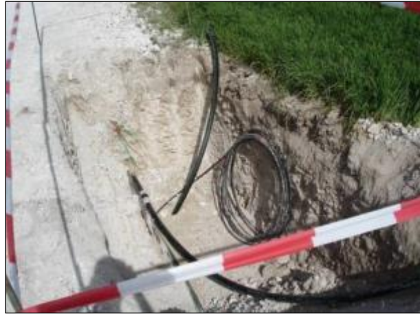
Figure 12 : Tranchée pour le passage des câbles électriques
