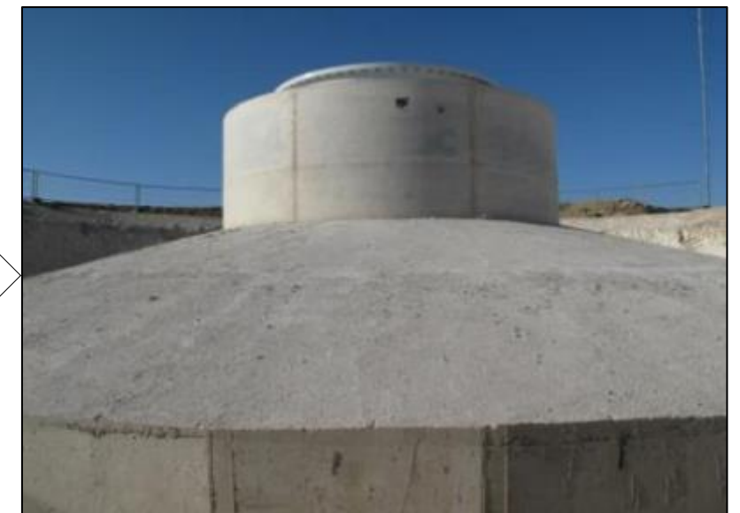
Le béton du fût est ensuite coulé
