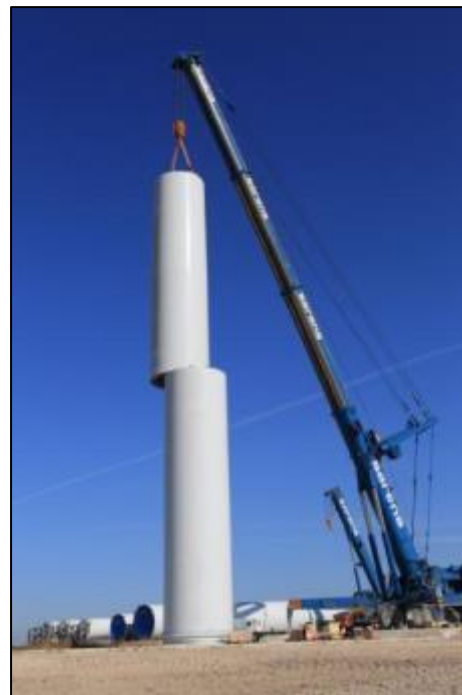
Figure 13 : Grues avant levage du moyeu
