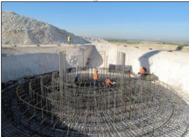
Mise en place du ferrailage
