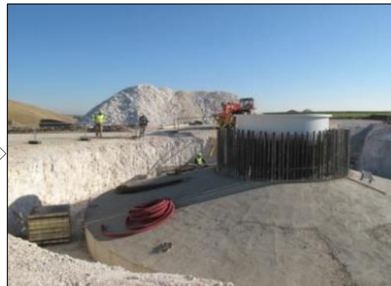
Une fois la semelle coulée, la virole est fixée à la partie supérieure de la fonction
