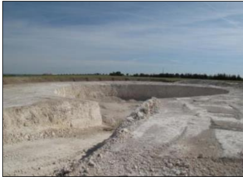
Réalisation des excavations
