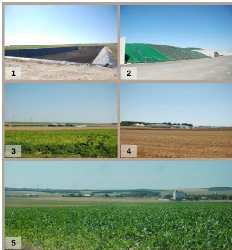
Illustration 8: Cliché 1, vue du bassin de stockage des digestats ; Cliché 2, vue des silos des intrants ; Cliché 3, vue de BIO GAZ GDC de la D65 au droit de l'usine CAPELLA ; Cliché 4, vue de l'usine STYREC et à droite d'une autre usine en construction ; Cliché 5, à gauche l'usine BIO GAZ GDC est visible avec ses dômes gris et plus au loin, avec des dômes verts l'usine de CAPELLA se devine derrière le premier bosquet d'arbre en partant de la gauche.
