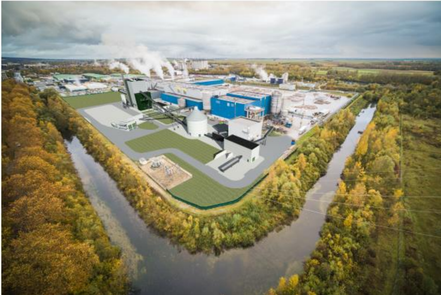
Figure 11 : Insertion paysagère du projet – Vue depuis l'angle nord-ouest
