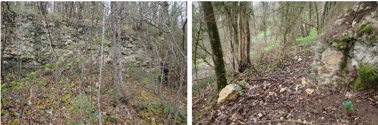
illustration 14 – Exemples de pierres et petits blocs observés (A : barre rocheuse d'environ 3 m de hauteur avec bancs calcaires sub-horizontaux en débit décimétrique, nappes d'éboulis avec pierres au sol inférieures à 10 litres unitaire ; B : affleurement de 3 m de hauteur avec éléments calcaires altérés dans une matrice marneuse, quelques pierres au sol et un petit bloc de 55 litres retenu par un arbre)
