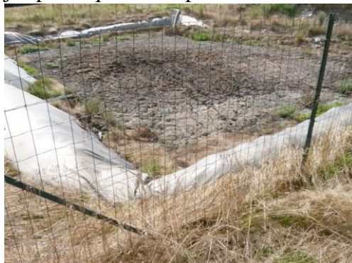
vue générale de la fosse
