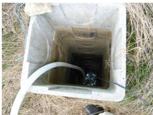
vue du puits de vidange des jus
