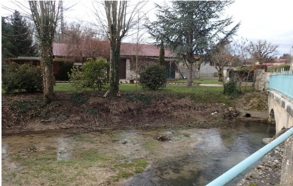
Illustration 11 – Erosion des berges le long du Landion dans le centre-bourg de Dolancourt (régression de la rive d'environ 1 m)
