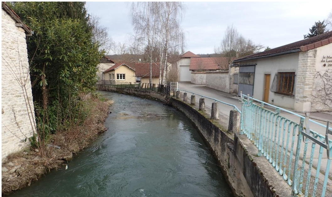
Illustration 12 – Mur de soutènement en rive concave du Landion dans le centre-bourg de Dolancourt
