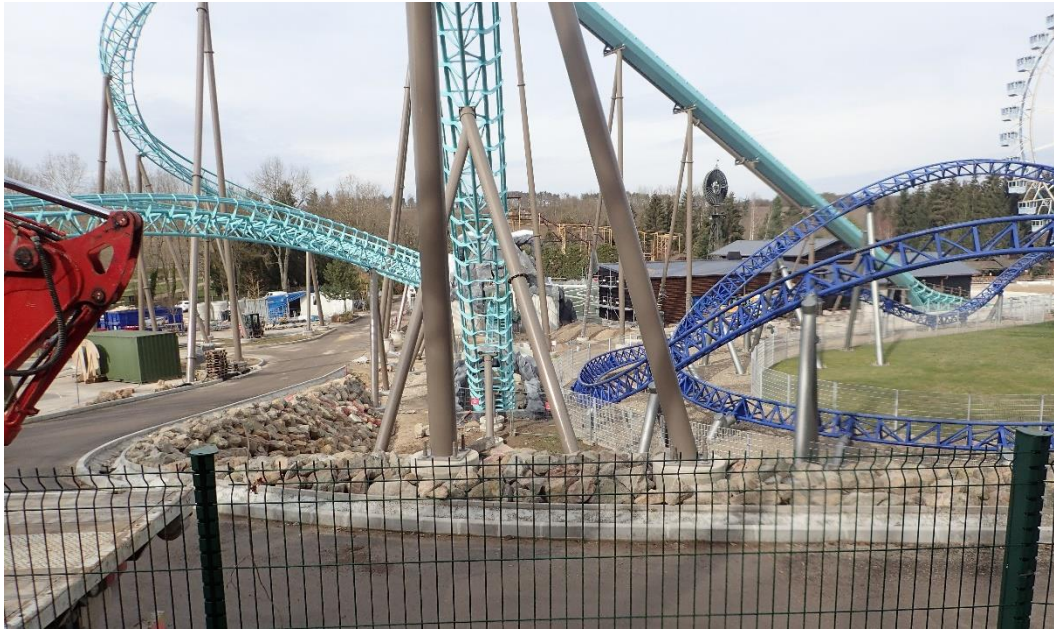
Illustration 13 – Enrochement mis en place en zone de déblais dans l'enceinte du parc d'attraction
