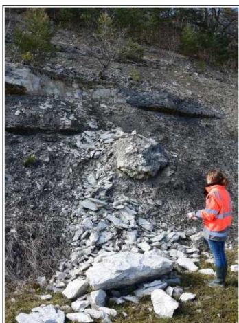
Chute de blocs à Bar-sur-Aube (Source : BRGM)
