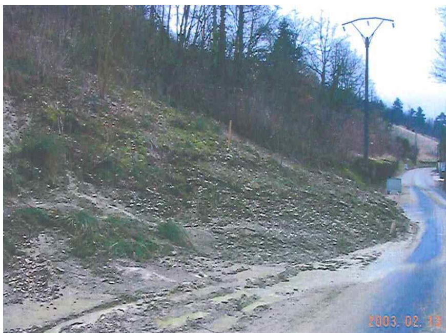
Illustration 2 – Photographie de la coulée sur la route (source : Ville de Bar-sur-Aube)
