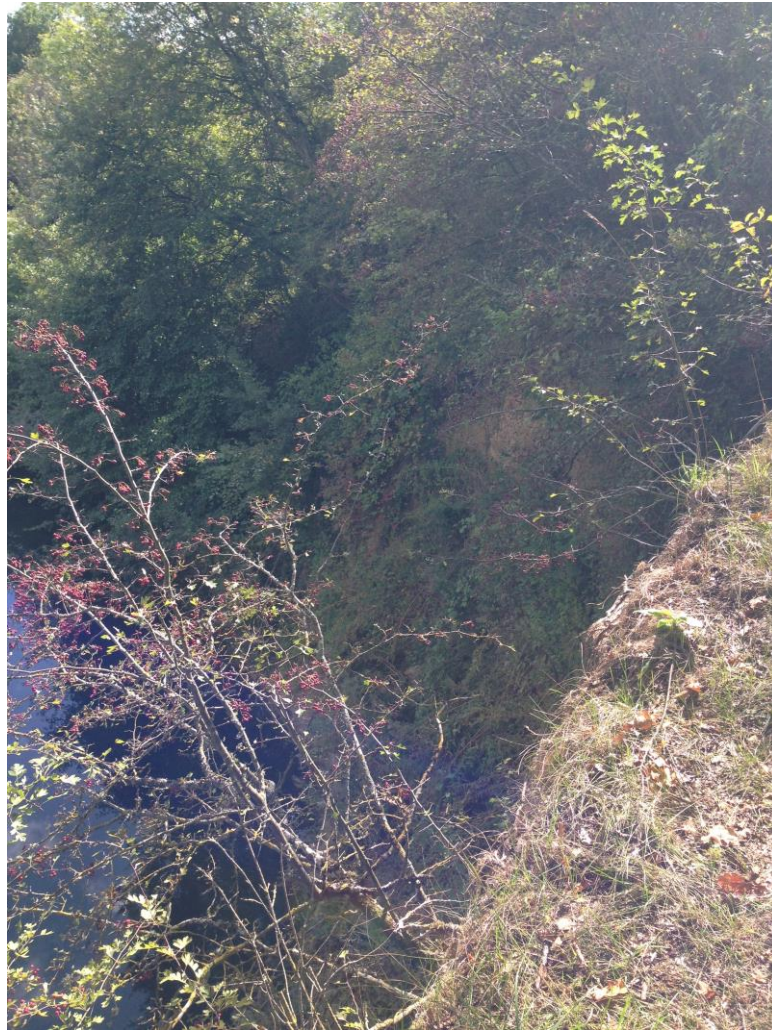
Illustration 20 – Sentier au niveau de la cote d’Aube (BRGM, 2015)
