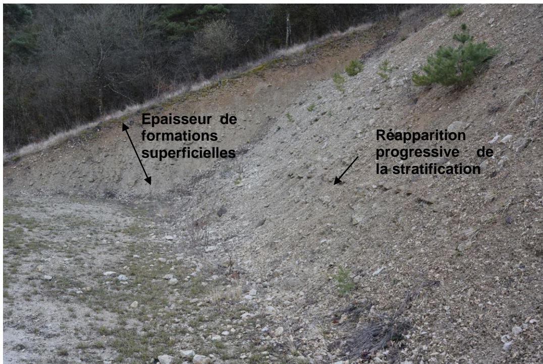
Illustration 19 – Formations superficielles en coupe (BRGM, 2015)
