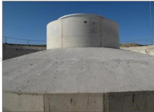
Le béton du fût est ensuite coulé
