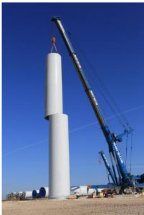
Figure 12 : Grues avant levage du moyeu
