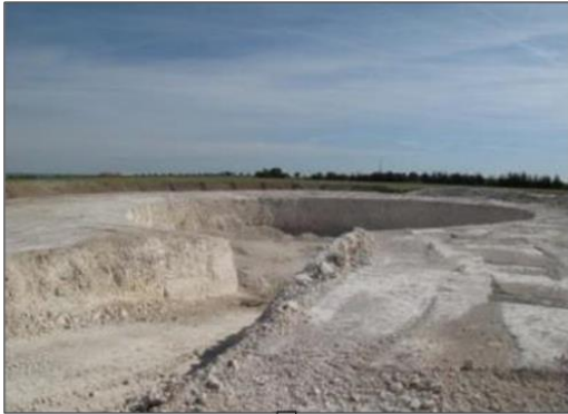
Réalisation des excavations
