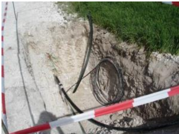
Figure 11 : Tranchée pour le passage des câbles électriques
