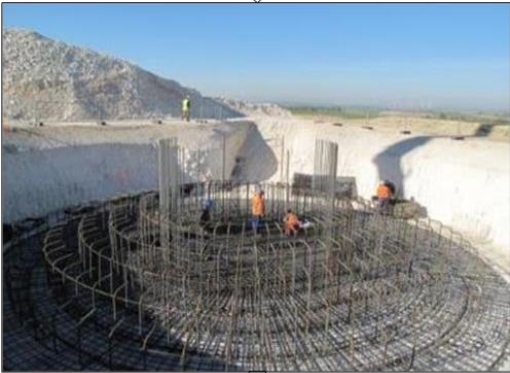
Mise en place du ferrailage
