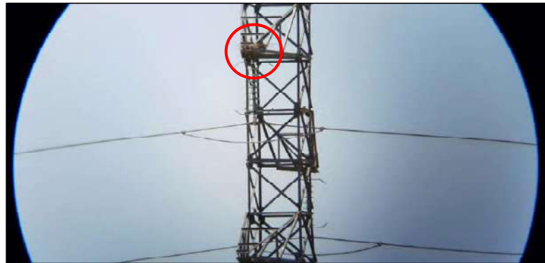
Figure 7. : Illustrations photographiques de nids construits sur des pylônes électriques et d'un individu posté sur la structure
