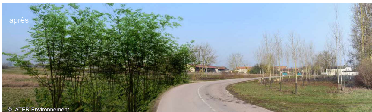
Fig. 161 : Plantation d'un écran végétal le long de la D71 au sud d'Ormes
