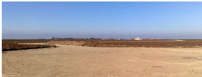
Figure 172 : Exemple d'aire de montage, grave compactée sur géotextile
