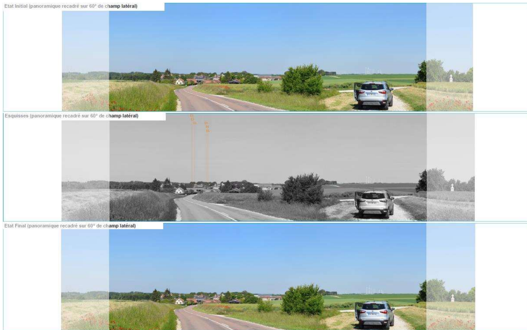
Figure 179 : Panorama du point de vue 3 (source : NEOEN, 2022)
