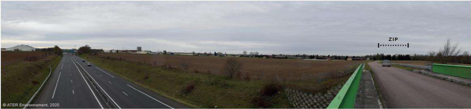
Figure 82 : Vue en direction de la ZIP depuis le pont de la D136 enjambant l'Autoroute des Anglais (A26)
