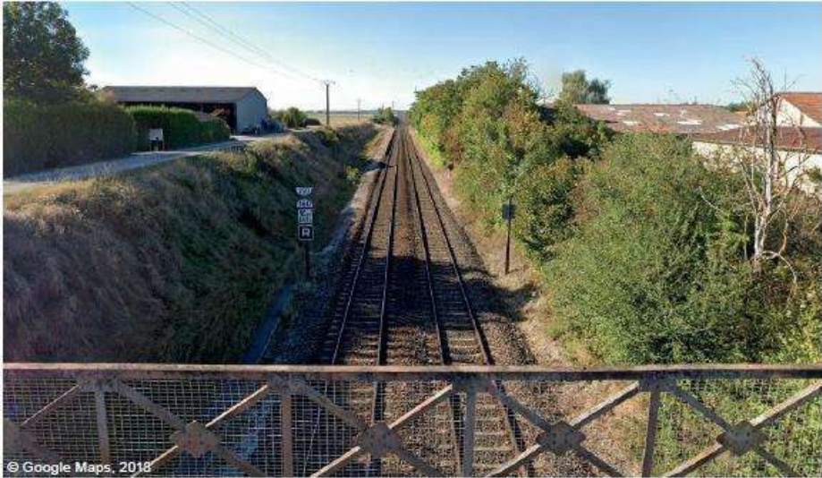
Figure 62 : Vue sur la voie ferrée rejoignant Troyes à Romilly-sur-Seine depuis la D375 au Sud de Méry-sur-Seine
