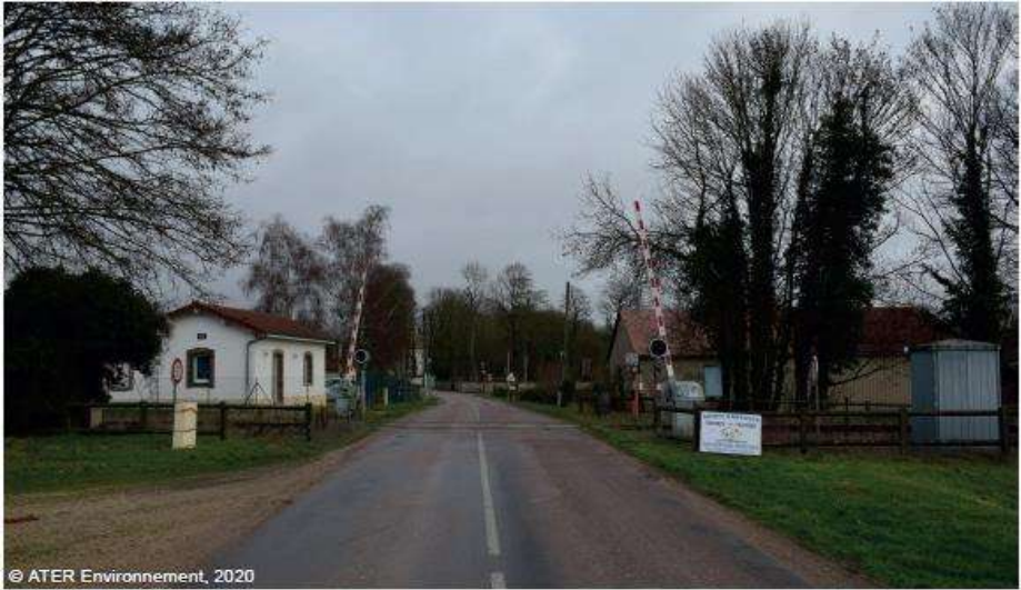
Figure 63 : Passage à niveau de Charmont-sous-Barbuise
