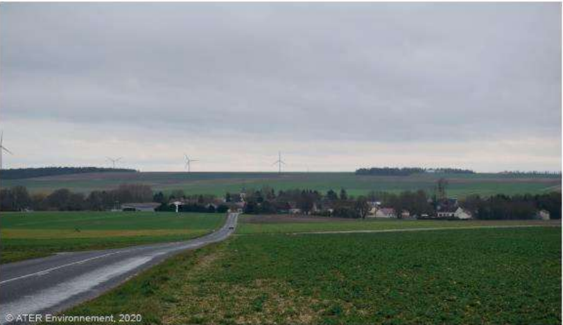
Figure 42 : Le bourg de Gourgançon, légèrement dans un creux le long de la Maurienne, masqué par les ondulations des plaines est alors perceptible depuis le sommet d'une crête
