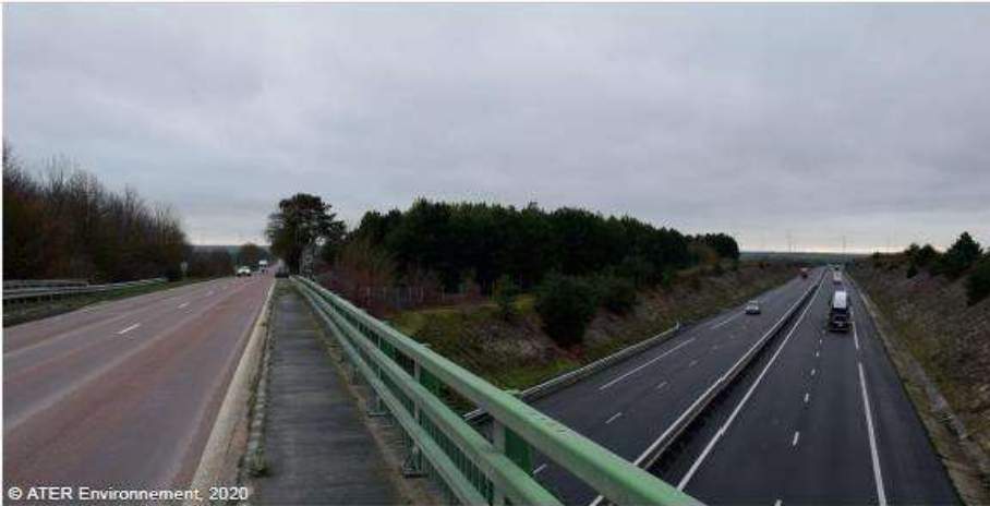
Figure 54 : Vue sur l'Autoroute des Anglais (A 26) depuis la D677 au Nord de Mailly-le-Camp, dont les talus autoroutiers limitent les vues extérieures
