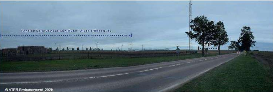
Figure 52 : Vue sur les parcs construits depuis la D447 à l'Est de Méry-sur-Seine
