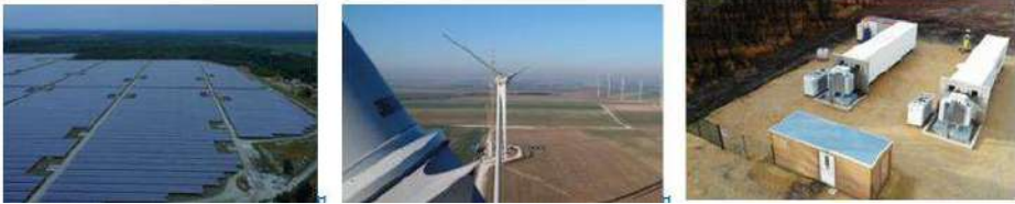
Figure 18 de gauche à droite, Centrale Solaire de Cestas (300 MWc), Centrale Eolienne de Bussy-Létrée (26 MW), et Azur Storage (6 MW, 6MWh) (source : NEOEN, 2019)
