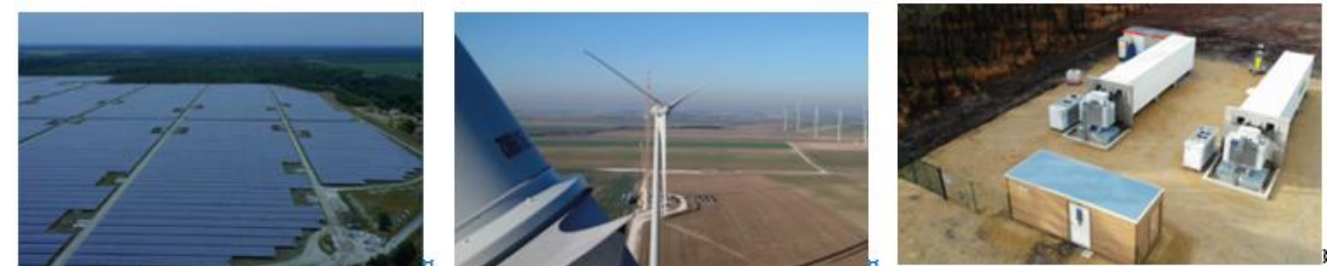
Figure 5 de gauche à droite, Centrale Solaire de Cestas (300 MWc), Centrale Eolienne de Bussy-Lettrée (26 MW), et Azur Stockage (6 MW, 6MWh) (source : NEOEN, 2019)
