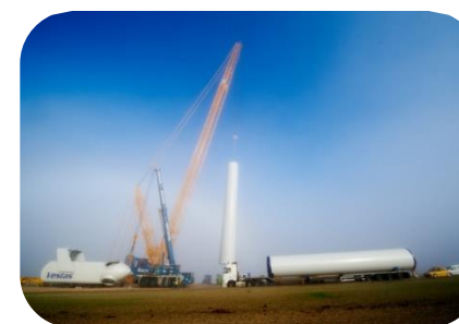
Livraison et Montage des tronçons de mâts
