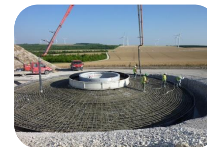
Coulage de la fondation
