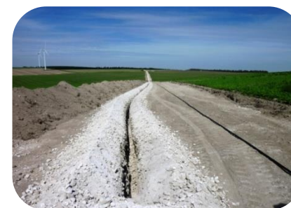
Réalisation des pistes et du câblage
