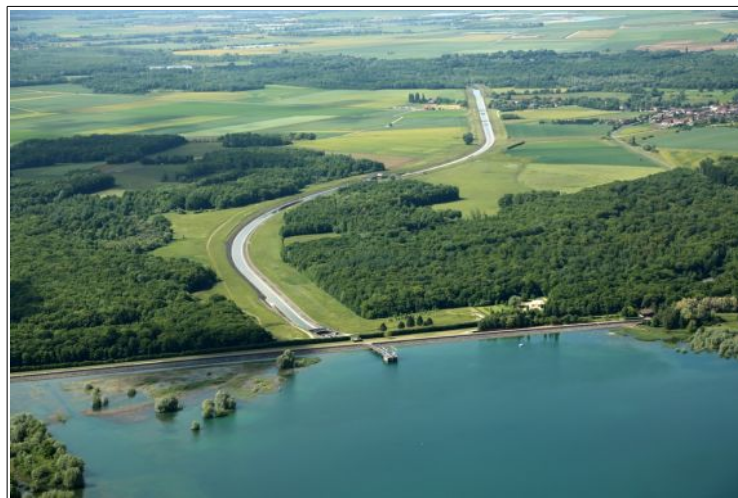
Barrage-réservoir Marne (Source : EPTB Seine Grands Lacs)
