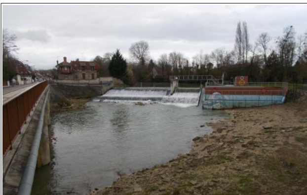
Déversoir de Saint-Julien-les-Villas (Source : Troyes Champagne Métropole)
