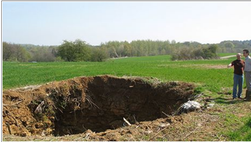
Effondrement d'une cavité souterraine (Source : Géorisques)
