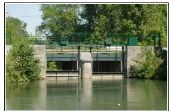
Ouvrage hydraulique de l'agglomération troyenne (Source : Troyes Champagne Métropole)
