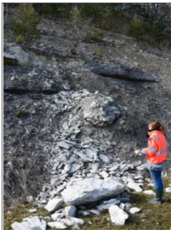
Chute de blocs à Bar-sur-Aube (Source : BRGM)
