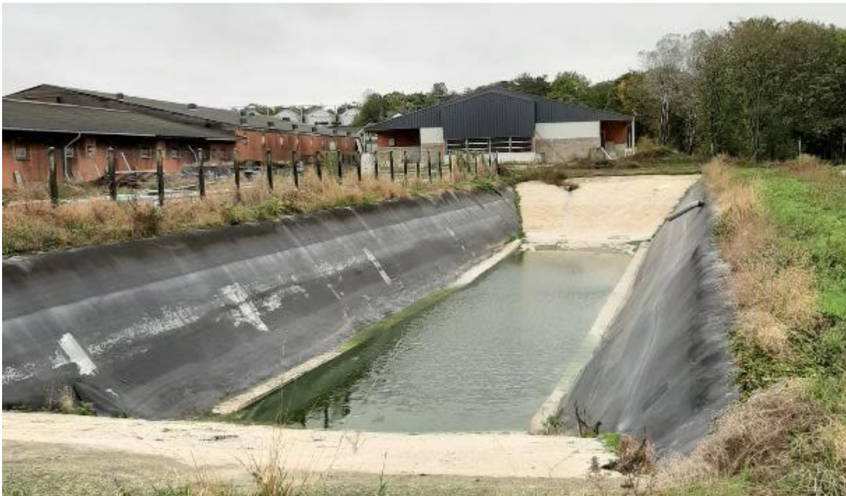
Prise de vue 6 : Vue sur la réserve incendie du site (en cours de remplissage avec les eaux pluviales)
