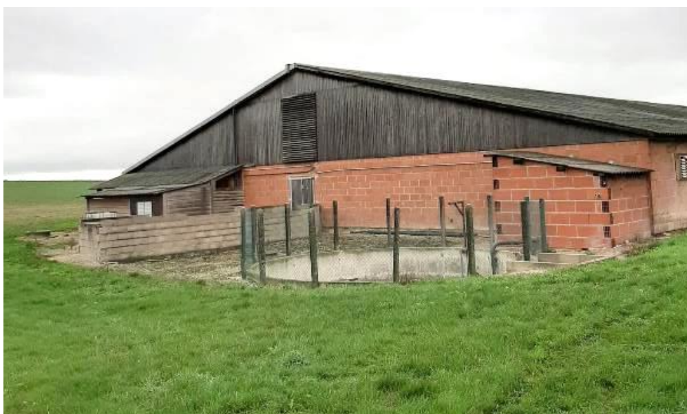
Prise de vue 10 : Vue sur la fosse tampon et le bâtiment proche de l'autoroute de Val-Saint-Jean
