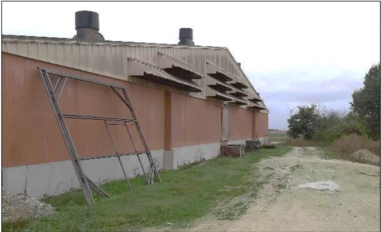
Prise de vue 3 : Vue sur le bâtiment d'engraissement objet de l'agrandissement
