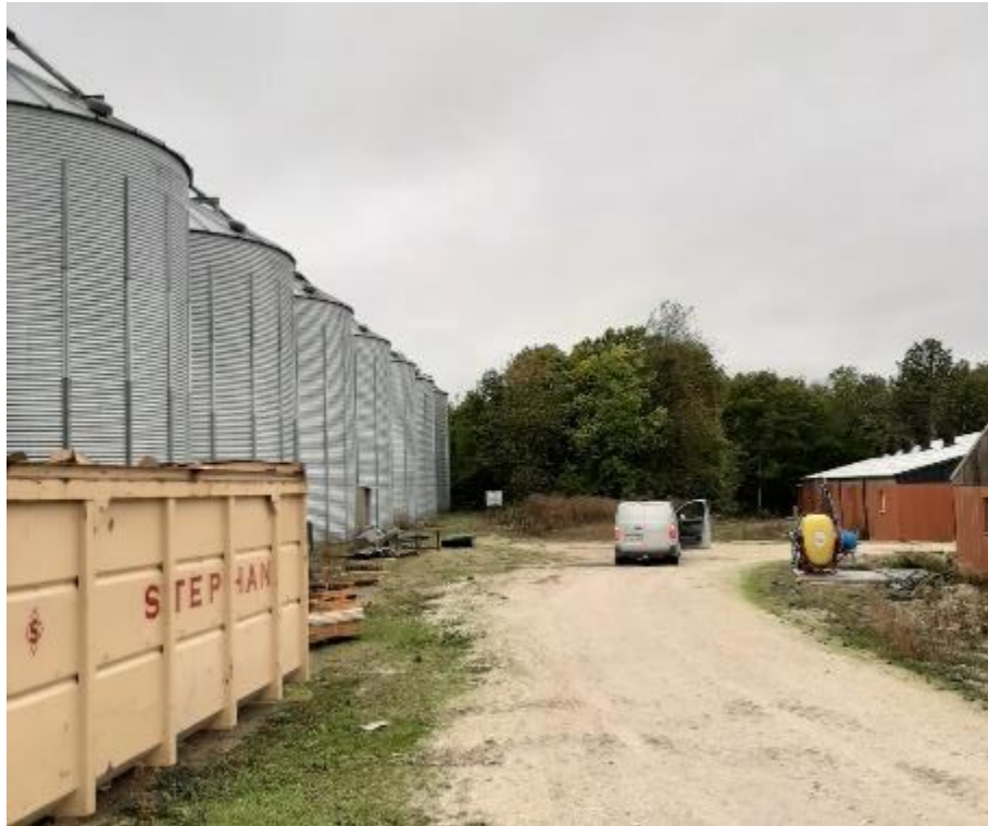
Prise de vue 1 : Vue sur les silos de stockage de la SCEA LA PROVIDENCE et du bâtiment attente saillie (à droite)
