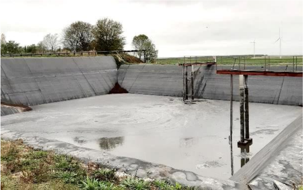
Prise de vue 5 : Vue sur une des lagunes de stockage (11 000 m 3 )
