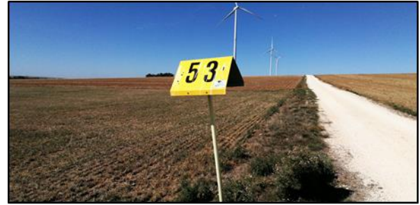
Canalisation de gaz
