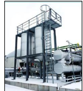
Filtre à charbon Source : GASEO
