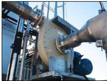
Surpresseur Source : GASEO
