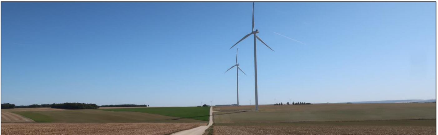
Vue depuis l'angle Nord-Ouest du site d'étude
