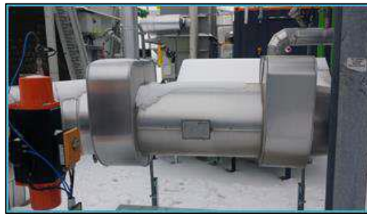
Echangeur de chaleur Source : GASEO
