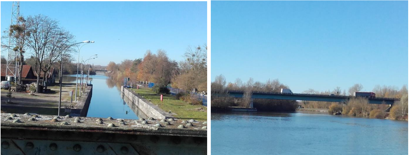
Photo 5 : Ecluse présente à l'entrée du canal et pont de la RD619 (Source : Antea Group)
