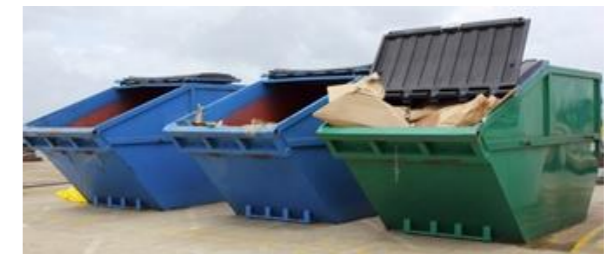
Exemple de bennes de stockage déchets en phase travaux
