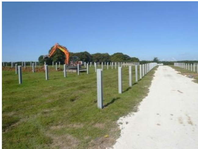
Photo 17 : Exemple de voie d'accès en matériaux concassés (Source : Kronos Solar)
