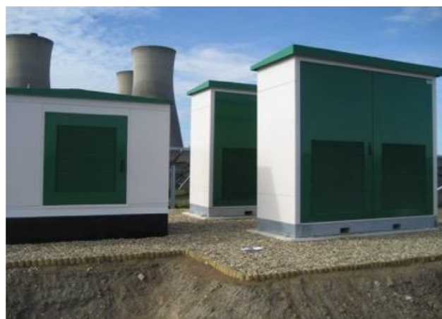
Photo 14 : Exemple de postes de transformation en images de synthèse (Source : Kronos Solar)
