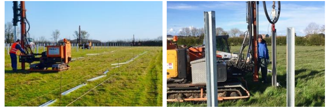
Photo 20 : Exemple de batteuse de pieux (Source : mkg-goebel.fr)
