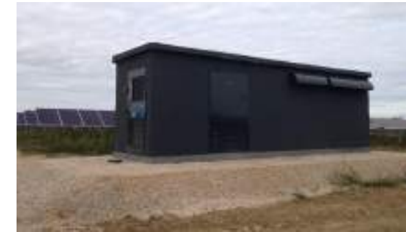
Photo 48 : Installation d'un poste de transformation (Source : Urbasolar)
