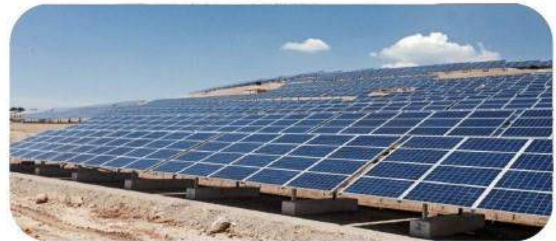
Photo 42 : Structures fixes sur longrines béton (centrale solaire URBASOLAR de Fuveau - 13)
