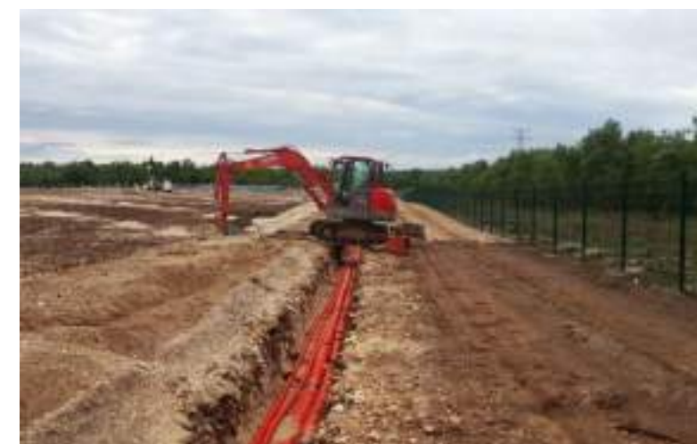
Photo 45 : Pose des câbles dans une tranchée (Source : Urbasolar)
