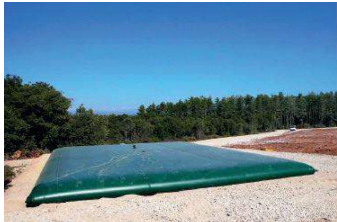
Photo 44 : Exemple de citerne (Source : Urbasolar)
