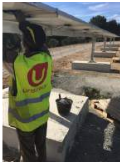
Photo 47 : Mise en place d'un module sur une table d'assemblage (Source : Urbasolar)
