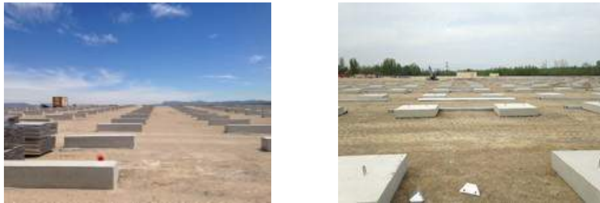
Photo 46 : Exemples d'utilisation de longrines béton sur les chantiers URBASOLAR Fuveau (13) et Lavernose-Lacasse (31)
