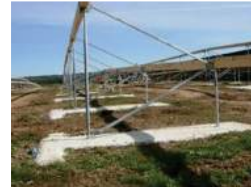
Figure 20 : Photographie d'une fondation en longrines
