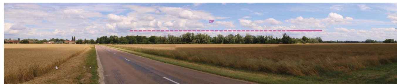
Photo 3 : Vue sur la ZIP, à 400 m à l'ouest au niveau de la RD1 (Source : Ora environnement)
